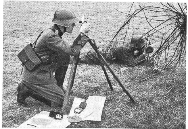
Photographie Nr. 1: Zens.-Nr. IX b B 3096. Die Richtstelle , wo der Zugführer mit Richtkreis, Flugbahnkarte, Mefydreieck, Thermometer, Barometer, Karte, Flugbahnkarte und event. Kompaß seine Berechnungen macht. Zur Bestimmung der Distanz hat er den Telemetermann bei sich.
