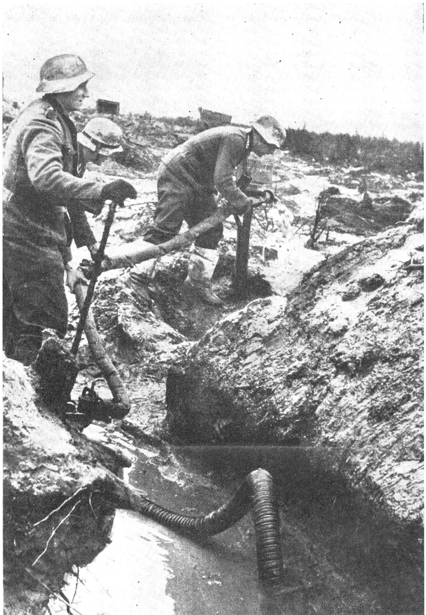
Deutsche Grabenbesatzung im Osten im Kampf gegen den Grabenschlamm mittels Hand-Wasserpumpe.
