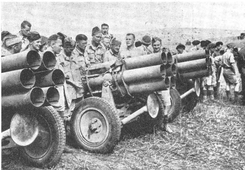
Deutsche Nebelwerfer (Mehrfachgranatwerfer) in Nordafrika von den Alliierten erbeutet. Die Rohre haben ein Kaliber von ca. 18 cm, die Geschosse werden auf elektrischem Wege zum Abschluß gebracht. Nach der Pneubereitung zu schließen, erfolgte der Transport dieser Geschütze durch Motorzug.
