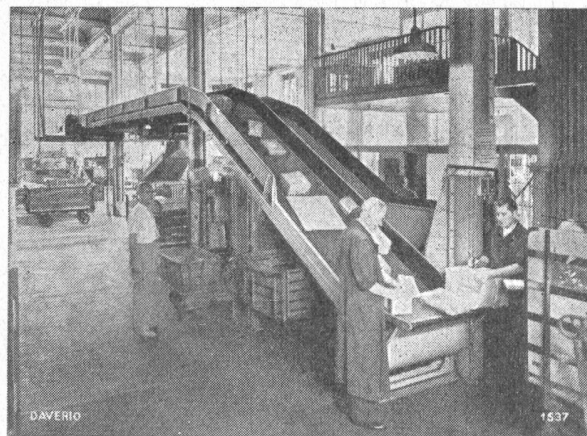
Teilansicht einer Paketförderanlage
