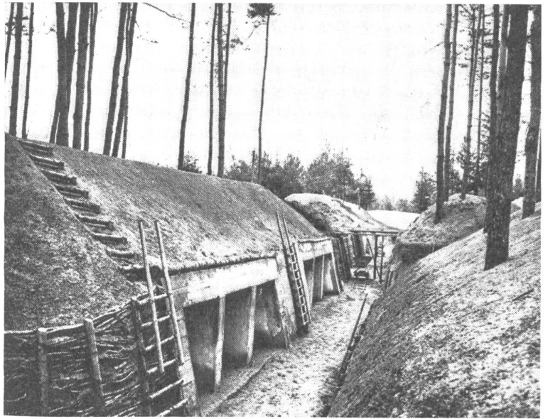
Betonunterstand in der Fortifikation Murten, die im Befestigungssystem von 1914/18 eine Schlüsselstellung einnahm. In monatelanger Arbeit wurden die Verteidigungsstellungen von Genie- und Infanterietruppen gebaut
