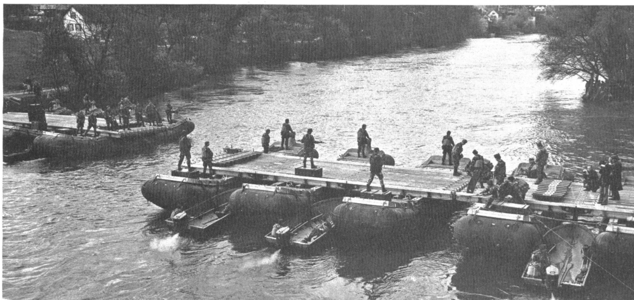
«Hindernisse sind da, um überwunden zu werden!» – Genietruppen beim Stegbau
