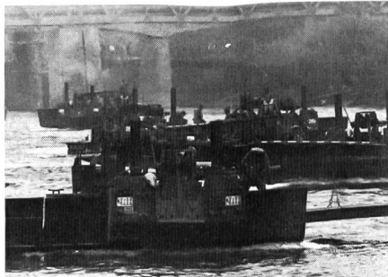
Brückenschlag über «die blaue Donau».
