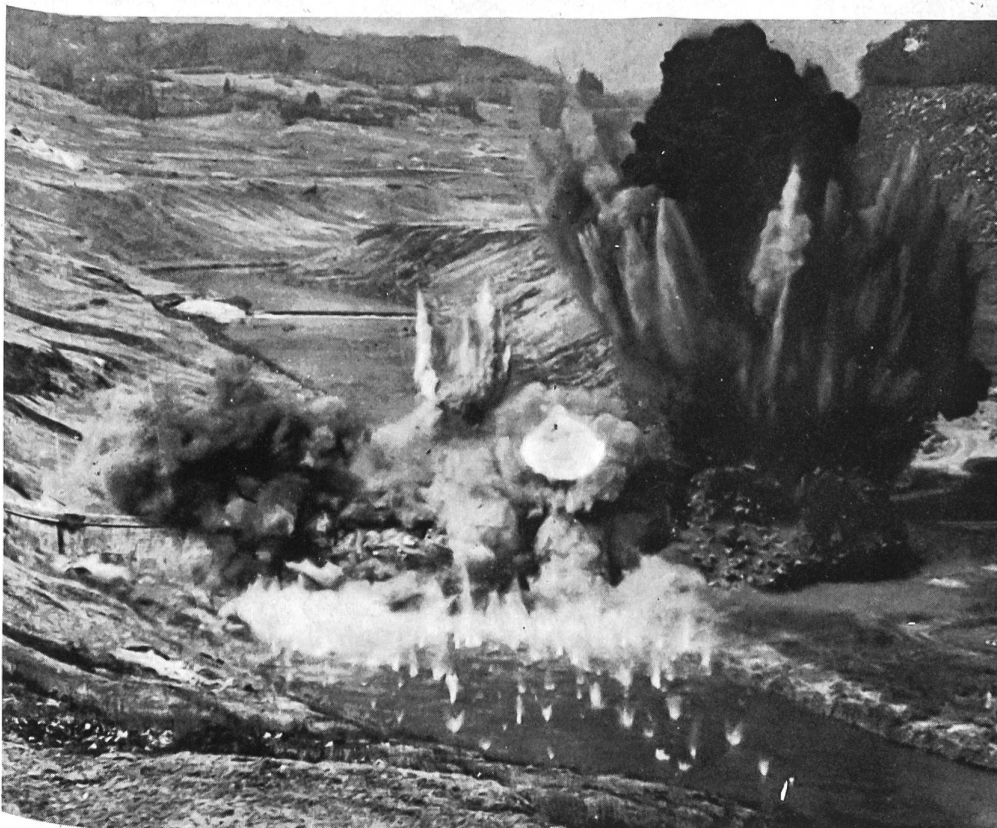
Sprengung eines Überganges
