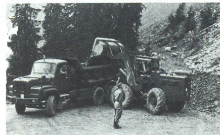
Einsatz der Baumaschinen im Suldtal.
