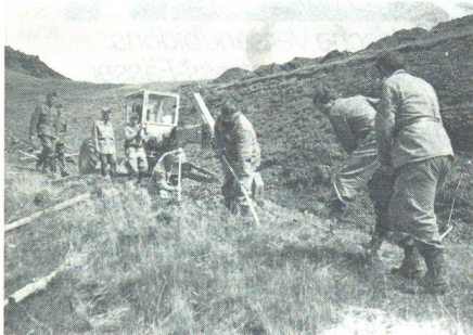
Das ist ein Schreitbagger, wie er zur Aushebung des Kabelgrabens am Lauberhorn gute Dienste leistet.
