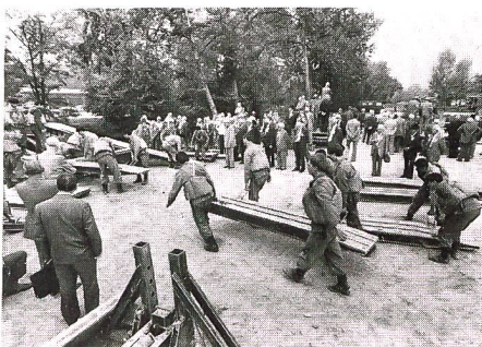
Junge Tessiner Wehrmänner demonstrierten den interessierten Veteranen den schulmässigen Einbau der «Festen Brücke 69» über einen Nebenarm der Aare.
