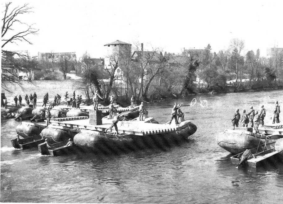
Einbau der 50-Tonnen-Schlauchbootbrücke über die Aare bei Brugg.
