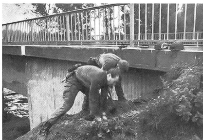
Brücke wird zur Sprengung vorbereitet
