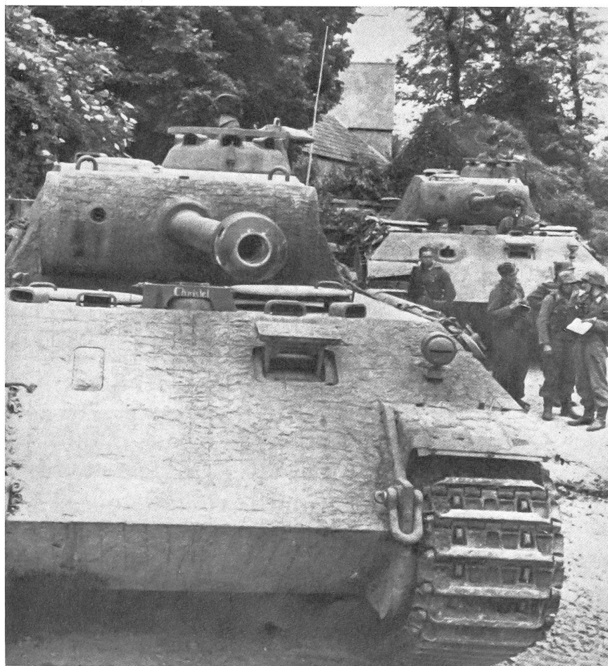
Deutsche Panzer Typ «Panther» in der Bereitstellung; stark abgeschrägte Fahrerfront
