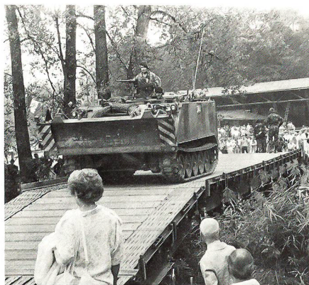
Kurze Zeit nach dem Einbau der Brücke 69 fährt der Geniepanzer 63 über das Wasserhindernis.
