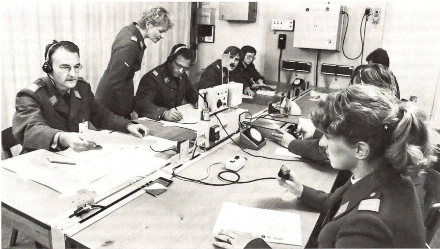
Blick in eine Warnsendestelle.
