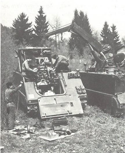
Die Panzermechaniker beim Ausbau eines Motors.
