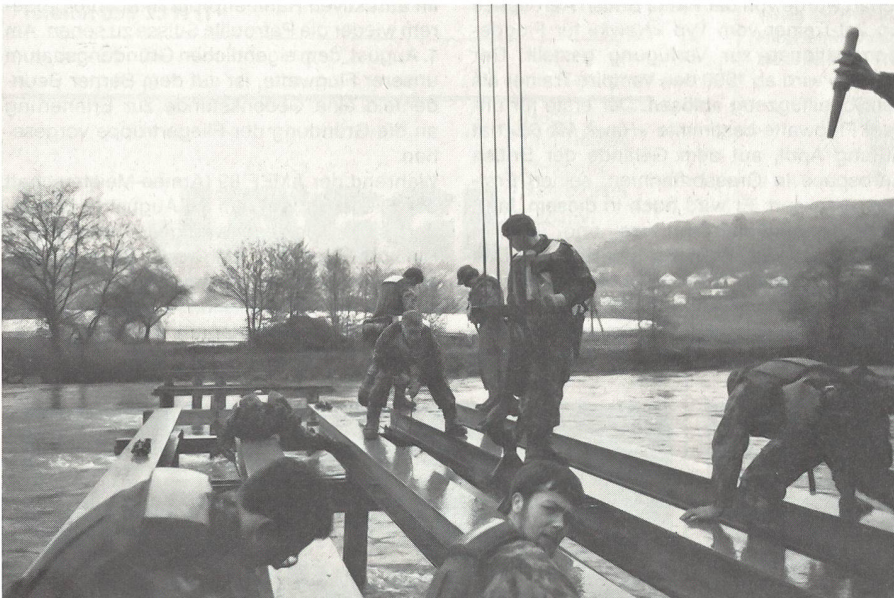
Versetzen der DIN 18 bei der DIN-Brückenausbildung
