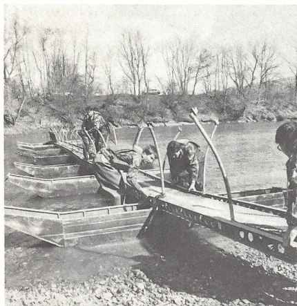
Einschieben der Elemente beim Steg 58
