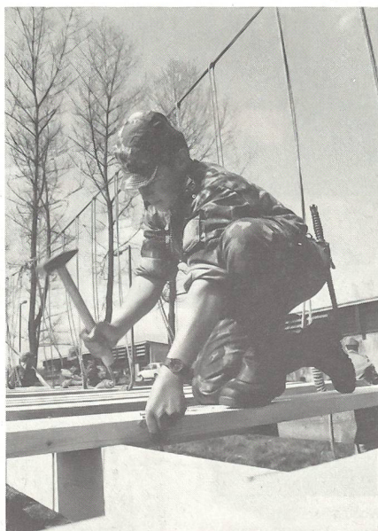
Erstellen des Oberbaues eines behelfsmässigen Seilsteges
