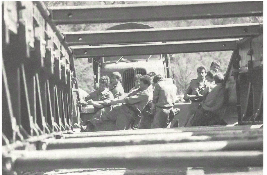
Gemeinsames Zupacken beim Einhängen des Uferbalkens an der Festen Brücke
