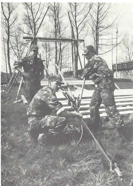
Spannen der Verankerung mit dem Seilzugapparat
