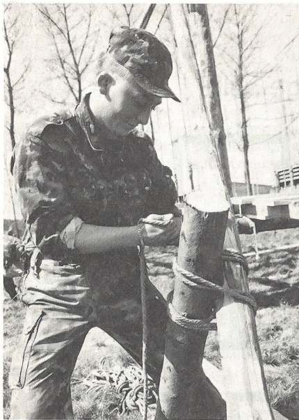
Seilwerk als Verbindungsmittel, die klassische Sappeurkunst
