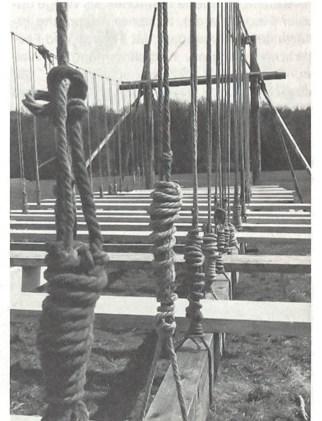
Fertig erstellter Behelfs-Seilsteg
