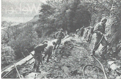
Hoch über der Rütliwiese arbeiten diese Rekruten der Genierekrutenschule Bremgarten am «Weg der Schweiz». (Bild hf)
