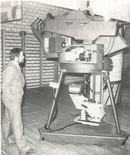
Eine Ausstellung liess genauere Einblicke in die drei Teilsysteme der neuen Panzerabwehrwaffe zu. Im Bild der Werferturm mit dem integrierten Panzerabwehrlenkwaffensystem TOW 2.
