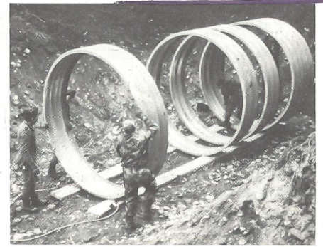
Die Einzelteile des Feldunterstandes werden von der Truppe in der ausgehobenen Grube zusammgebaut. Nachher wird der Unterstand mit dem Aushub zugedeckt.
