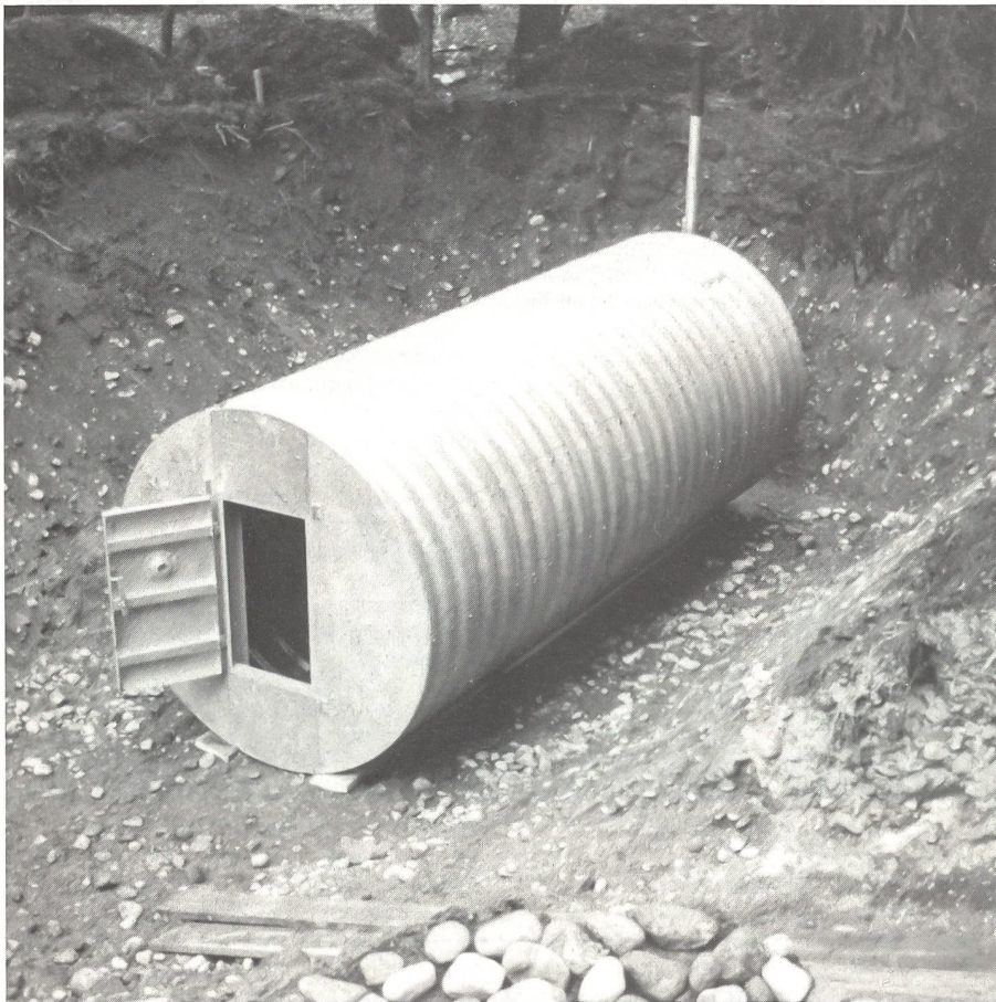
Feldunterstand in der offenen Grube montiert, Front- und Rückwände schliessen den zylindrischen Körper ab.
