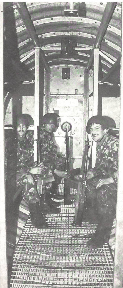
Drei Wehrmänner im neuen Feldunterstand 88 in Sicherheit. Es handelt sich um den vorgefertigten Schutzbau von Dr Ing Koenig AG.
