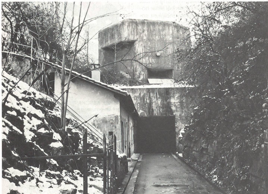
Haupteingang der Festung Reuenthal mit darüberliegendem Beobachtungsbunker B1, ausgerüstet mit einem Maschinengewehr 11, Scharten für leichte Maschinengewehre sowie einem Artillerie-Beobachtungsstand. Links vom Eingang befindet sich das Wachtgebäude.
