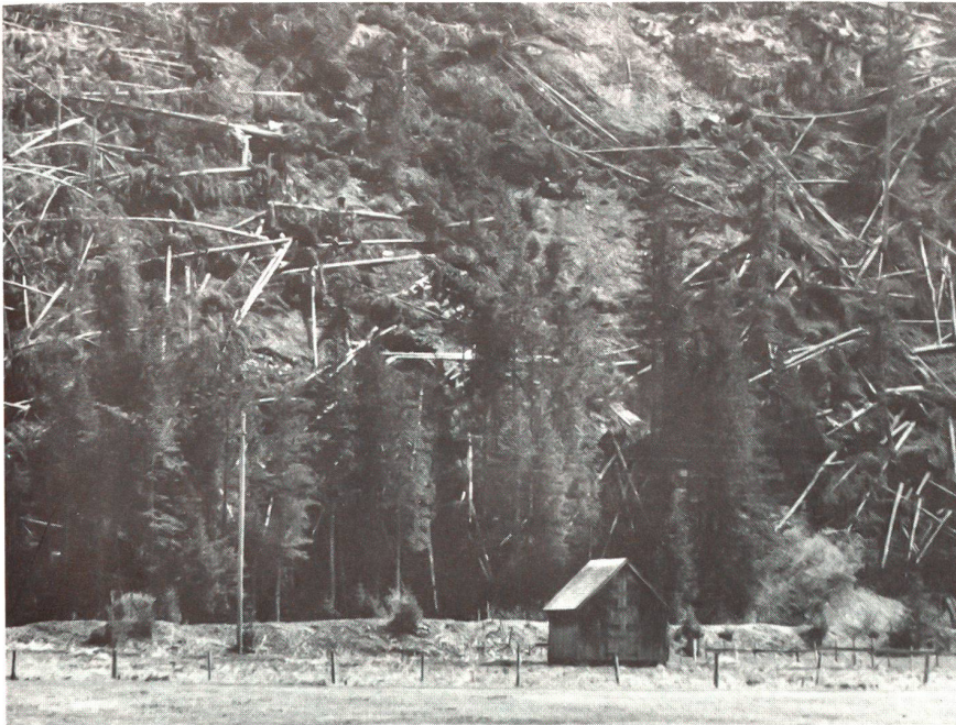
Fatale Sturmschäden im Schutzwald.
