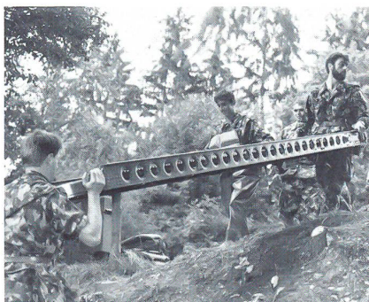
Kräftige Arme sind nötig, um die einzelnen Elemente an die Einbaustelle zu tragen.
