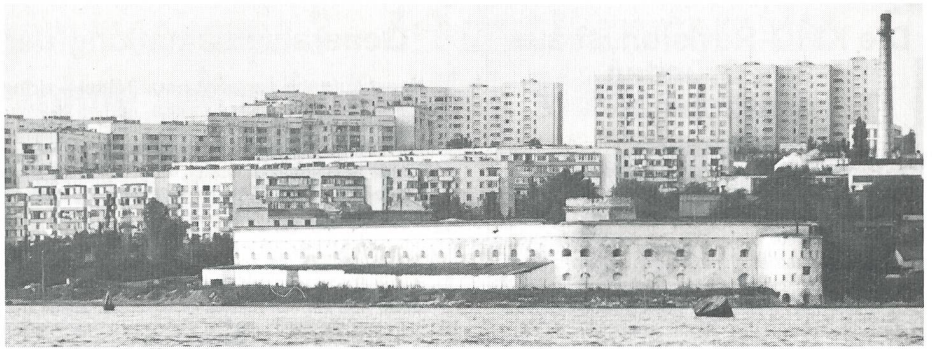
Blick auf die ehemalige Batterie «St Michael» im Hafen von Sewastopol (Bauzeit zwischen 1834 und 1852). Dahinter neuere Wohnquartiere.
