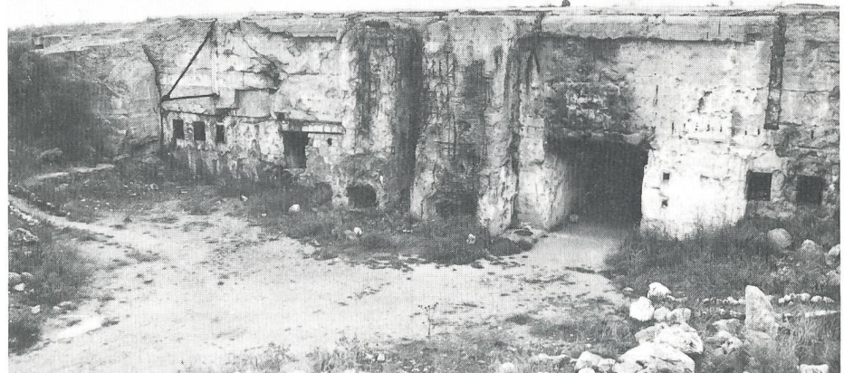
Eingangswerk der 1942 gesprengten Küstenbatterie «Maxim Gorki II» (ehemalige Bewaffnung zwei 30,5-cm-Zwillingtürme) im Süden der Stadt.
