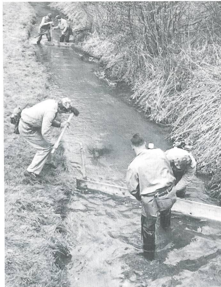
Errichten einer improvisierten Öl-Bachsperrre
