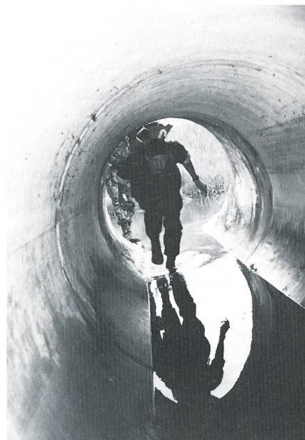
Auch die Kanalisation der Stadt Yverdon muss durchquert werden.
