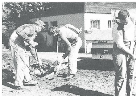
In 7500 Frondienststunden wurde in den Jahren 1971 bis 1974 das Eigenheim auf dem Seltisberg gebaut.
