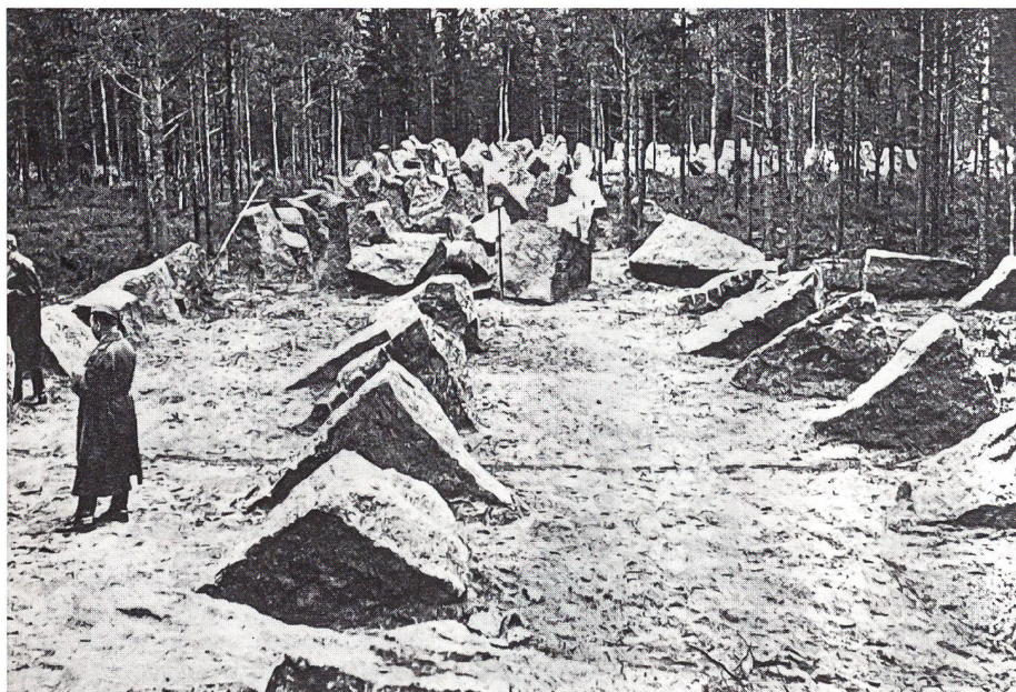
Finnisches Panzerhindernis aus Granitblöcken. Aus solchen Sperrern bestanden die finnischen Verteidigungslinien auf der Karelischen Landenge.
