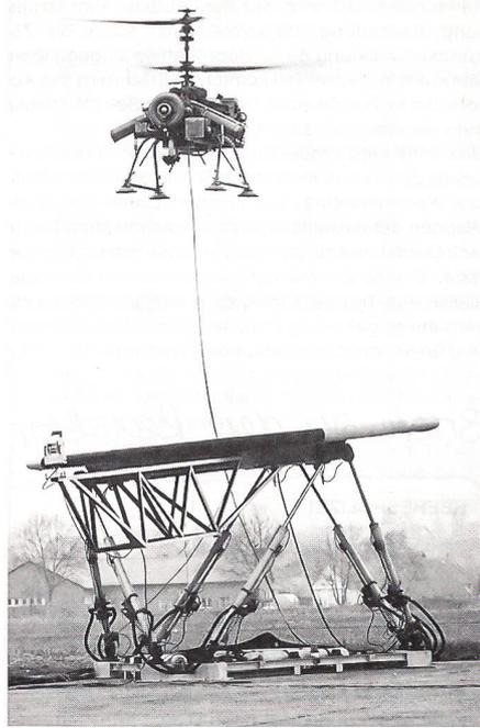
programmgesteuerte Streckenflüge nach vorgegebenen Wegpunkten Änderungen der vorprogrammierten Routen während des Fluges, direkte Bildübermittlung bzw Bildübertragung usw vorzunehmen. Kurz: Die neuartige Rotorplattform soll als Aufklärungsdrohne von Schiffen und Booten aus manövrierbar sein. — Unser Bild: Start von «Seamos» von einer automatisch bewegten Plattform (die die Schiffsbewegungen simuliert) zum Einsatz. *tic*
