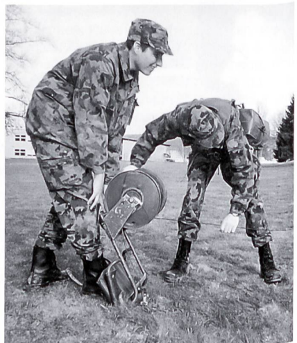
Telefonleitungsbau: Verlegen des Kabels.
