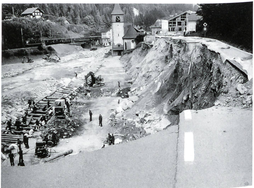
Die Rettungstruppen im Einsatz: bei Überschwemmungen
