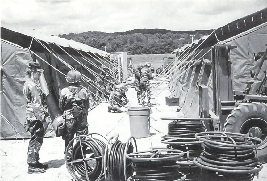
Aufbau des mob Feldspitals. Dabei helfen alle Angehörigen (Ärzte, Pflege- und Betriebspersonal) der Reserve-Kompanie mit. In zwei Tagen wird eine erste, in vier Tagen eine volle Betriebsbereitschaft erreicht.
