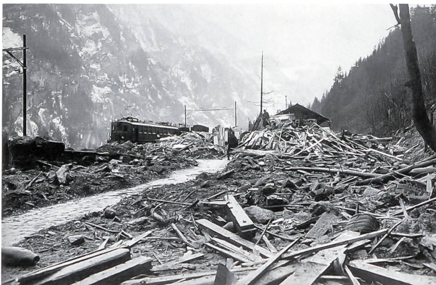
Zerstörungen entlang der Lötschberglinie
