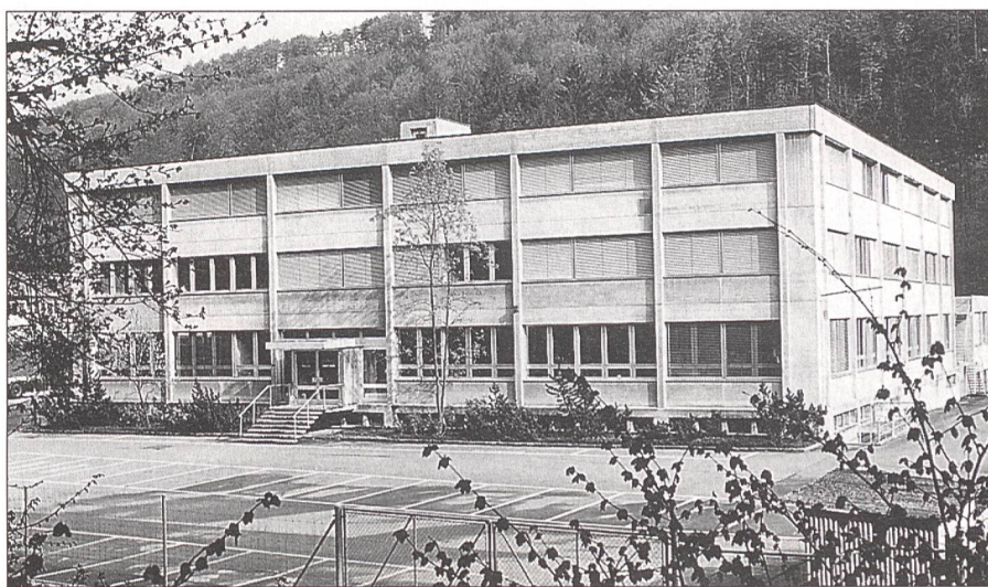
Das seit 1975 in Betrieb stehende Zeughaus.
