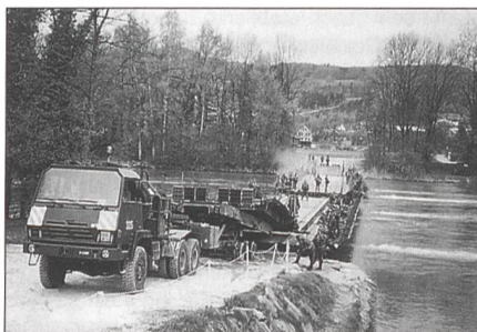
Aufstellen der Schwimmbrücke
