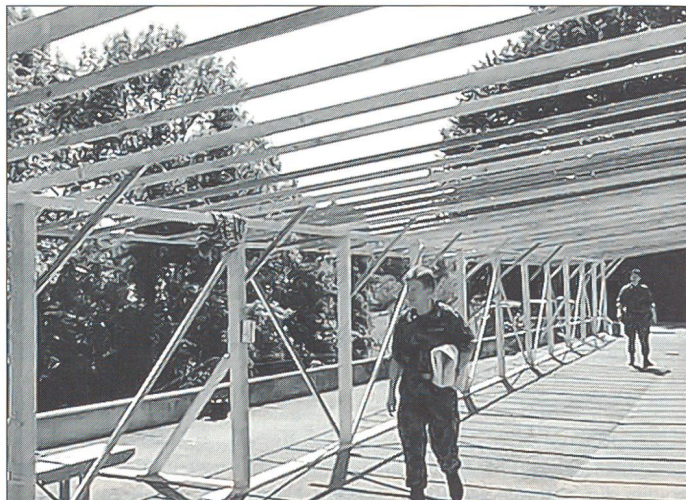
«Veranda» im Rohbau.
