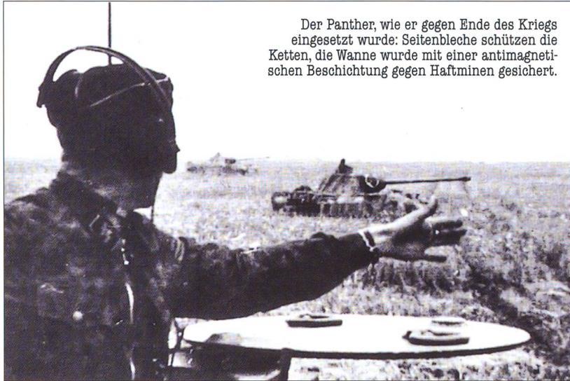
Der Panther, wie er gegen Ende des Kriegs eingesetzt wurde: Seitenbleche schützen die Ketten, die Wanne wurde mit einer antimagnetischen Beschichtung gegen Haftminen gesichert.
