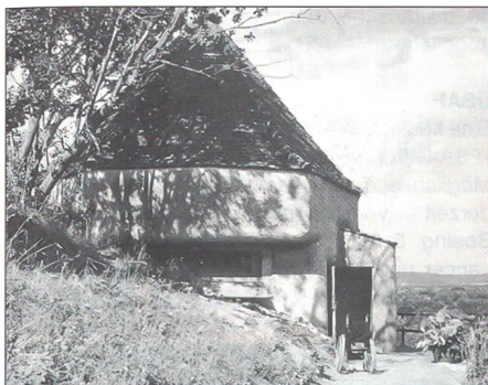
Der Bunker «Räbhüsi» wurde vom Dickicht freigelegt und soll als Zeitzeuge erhalten werden.
