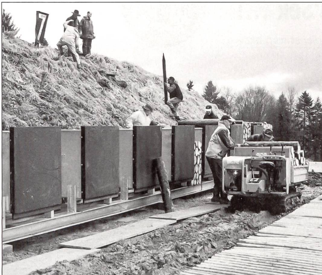
Erich Eichenberger und Walter Kägi (hinter dem Transporter) füllen die Zwischenräume mit Rundhölzern.
