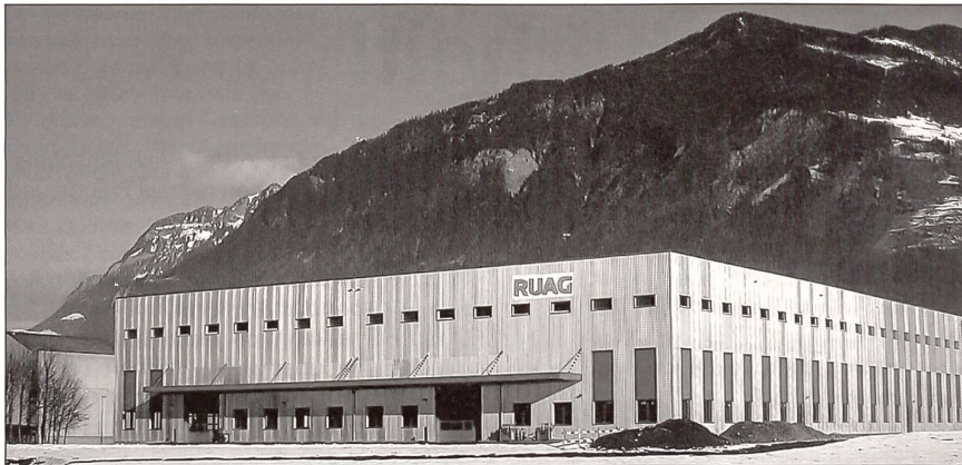
Neue Produktionshalle für RUAG Components in Altdorf.
