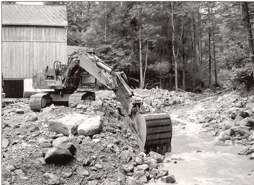
Das Bachbett des Brudererbachs wird ausgebaggert.
