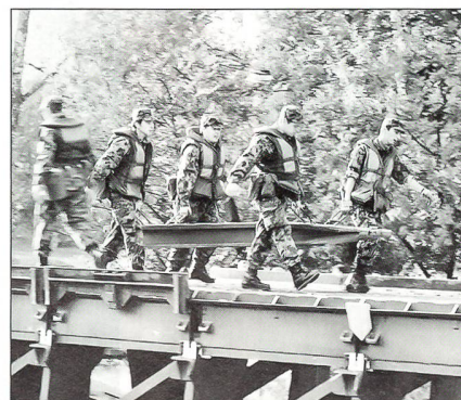
Beim Bau der Festen Brücke 69
