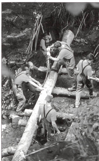
Instandstellungsarbeiten nach Unwetter im Emmental.
