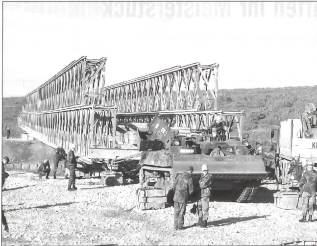
800-PS-Pionierpanzer zieht die auf Rollen gelagerte Brücke.
