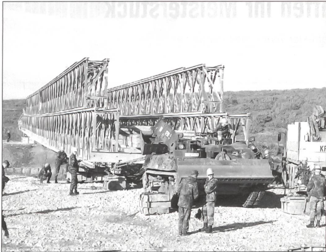
800-PS-Pionierpanzer zieht die auf Rollen gelagerte Brücke.
