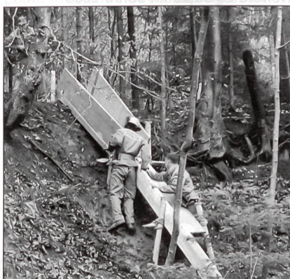
Ein Schuttkanal wird erstellt.
