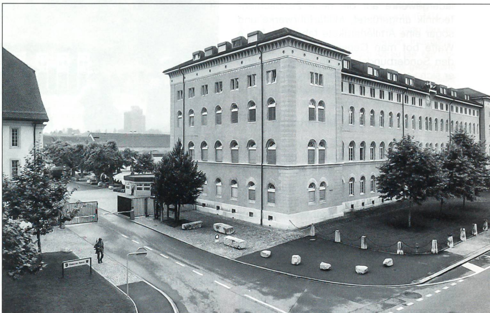
Nach langem Disput wurde die Kaserne Aarau mitten in der Stadt belassen und 1982 umgebaut. Die Fassaden des repräsentablen Gebäudes wurden in toskanischer Gotik, die auch Münchner Rundbogenstil genannt wird, belassen. (Bild Baudepartement/ZWA aus Buch «Helm auf!»)
