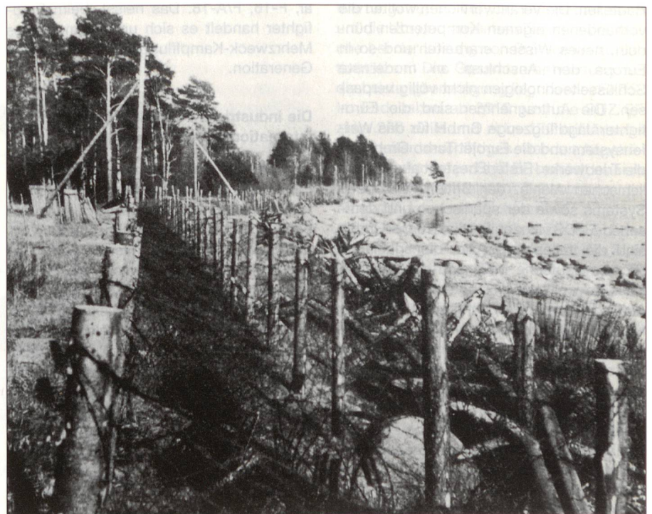
Panzerabwehrhindernis vor der Viipuri-Vuoksi-Linie im Bau.
